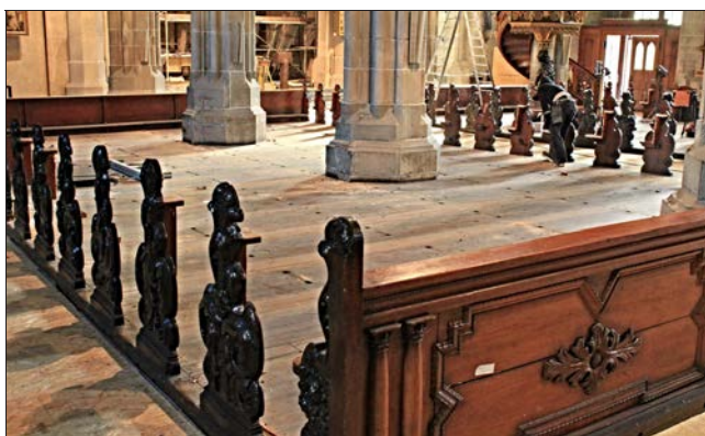
Die Docken werden mit den neuen Bänken wieder eingebaut.
