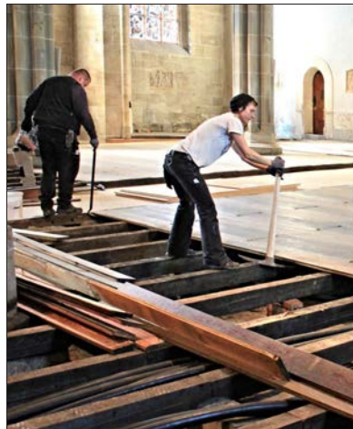
Die Bretter des Fußbodens werden abgenommen. Man erkennt den Kalkschlag in den einzelnen Feldern.
