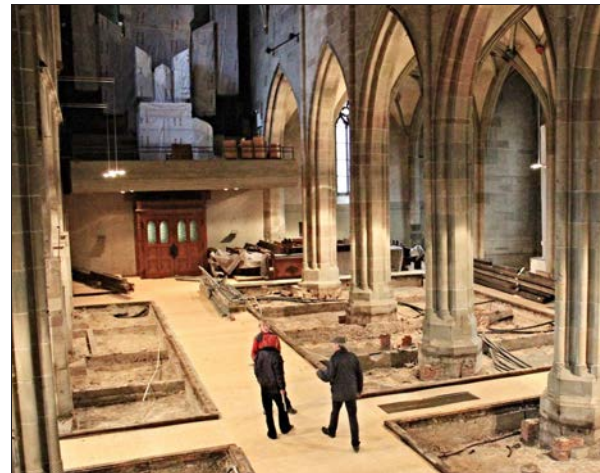
Die Bretter des Fußbodens werden abgenommen. Man erkennt den Kalkschlag in den einzelnen Feldern.
