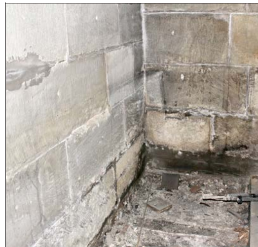
Die linke Wand ist bereits gereinigt, der hinteren Wand steht dies noch bevor. Fotos: Hildebrandt
