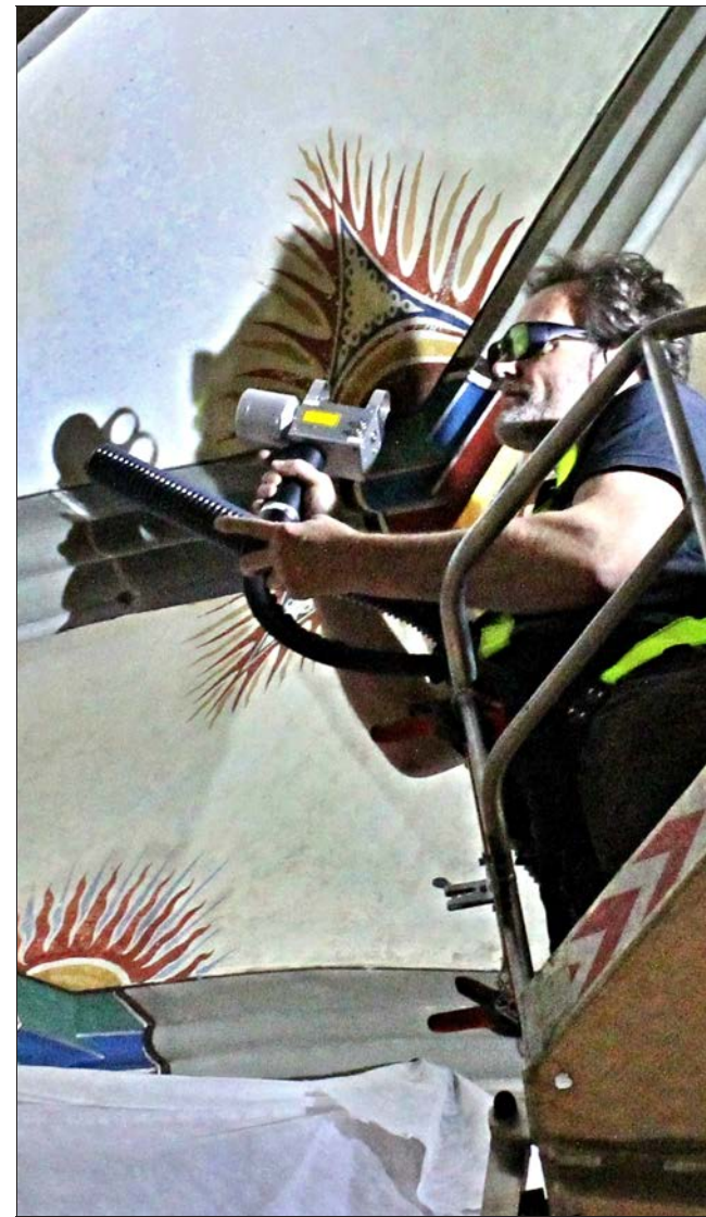
Restaurator Fabian Schorer mit dem Laser in der rechten und dem Absaugrohr in der linken Hand
