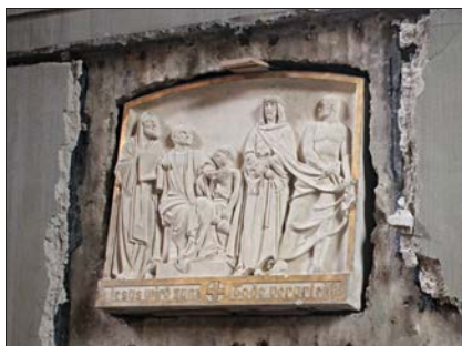
Bild eins (von links): Die Kreuzwegstation kippt nach hinten. Bild zwei: Dahinter kommt eine Natursteinmauer zum Vorschein. Bild drei: Fugen werden ausgekratzt und mit »Opfermörtel« verfüllt. Bild vier: Nicht alles ist echter Stein.
