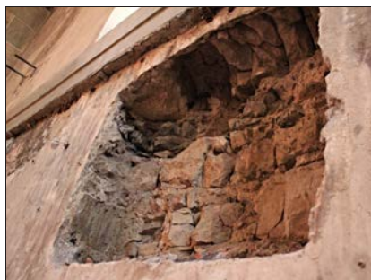
Bild eins (von links): Die Kreuzwegstation kippt nach hinten. Bild zwei: Dahinter kommt eine Natursteinmauer zum Vorschein. Bild drei: Fugen werden ausgekratzt und mit »Opfermörtel« verfüllt. Bild vier: Nicht alles ist echter Stein.
