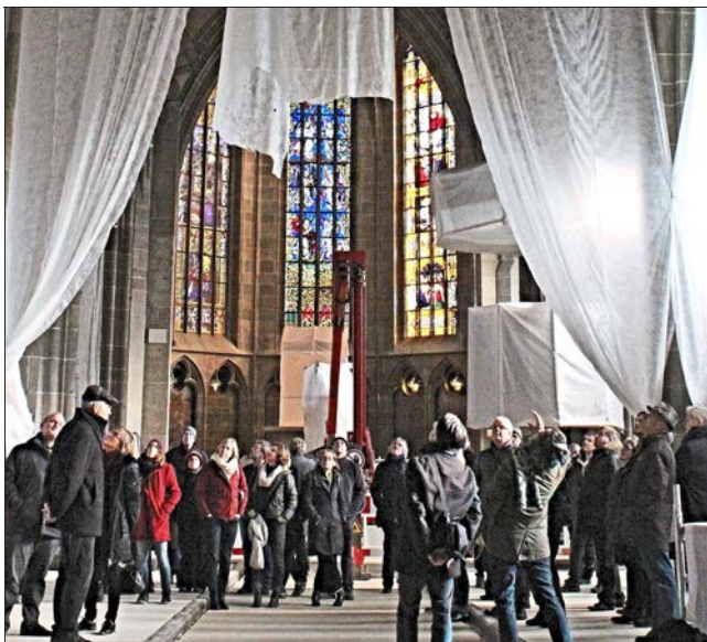
Vorhang auf: Etwa 60 Restauratoren und Architekten sind nach Rottweil ins Münster gekommen, um sich über das »Untersuchen und Reinigen mit Abstand« zu informieren.
