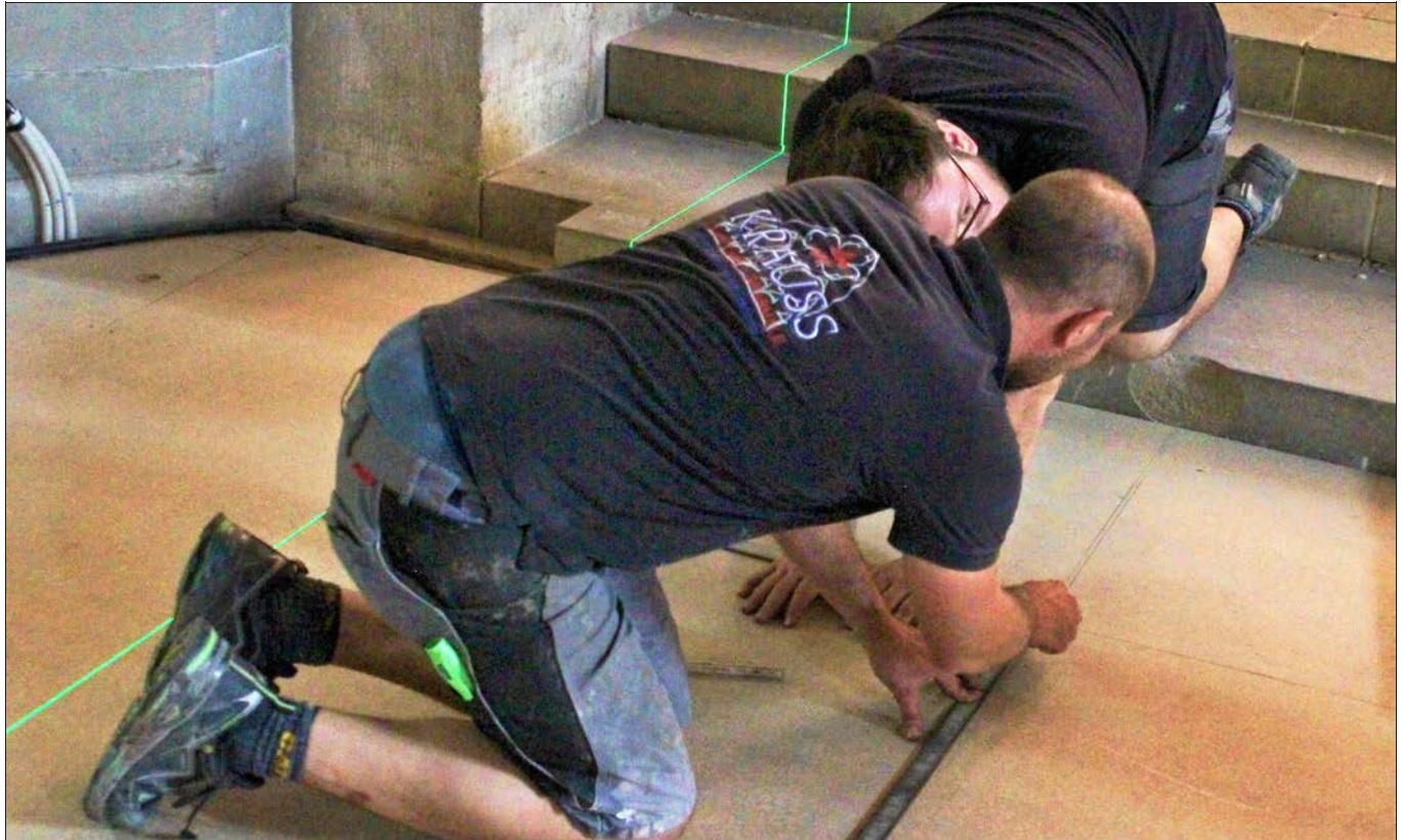
Die Steinmetze arbeiten am Reißboden. Der Laserstrahl ist im Bild grün zu sehen.
