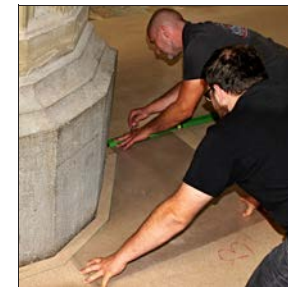
Das Abnehmen der Schablonen erleichtert die Produktion in der Werkstatt.
