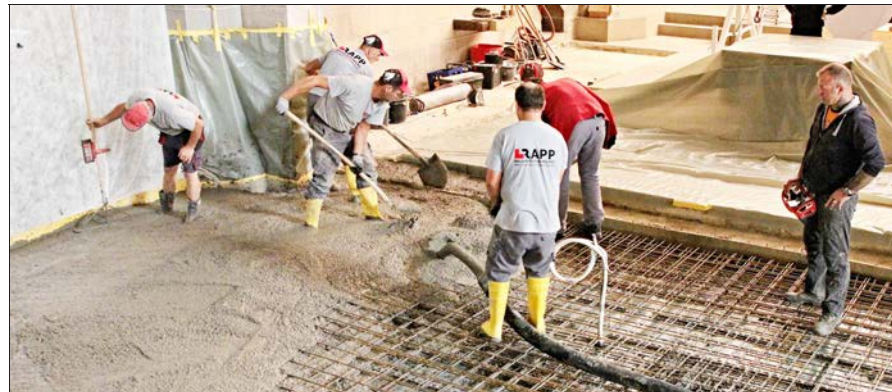
Die Arbeiter betonieren die Altarzunge.
