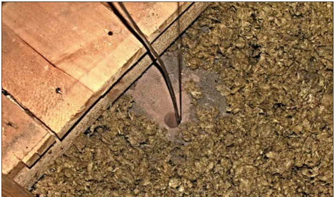
Fast nicht mehr zu sehen sind die Wandleuchten im Kirchenschiff (links). Durch ein Loch im Gewölbe (rechts) werden von oben die Kabel und die Aufhängung gelegt.
