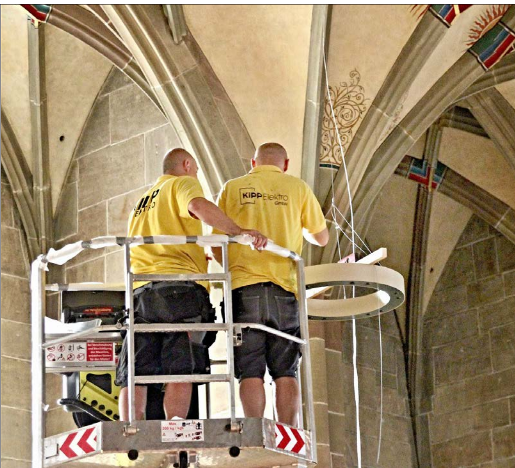
Im Seitenschiff Nord montieren Handwerker die Hängelampen (links). Die Abstimmung mit den Kollegen erfolgt per Handy (rechts).
