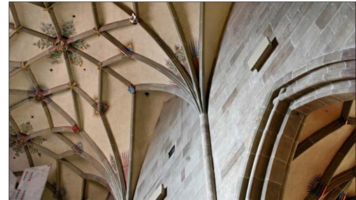
Fast nicht mehr zu sehen sind die Wandleuchten im Kirchenschiff (links). Durch ein Loch im Gewölbe (rechts) werden von oben die Kabel und die Aufhängung gelegt.
