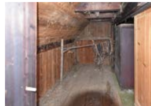
So sah das Elternbad vor der Sanierung aus.
