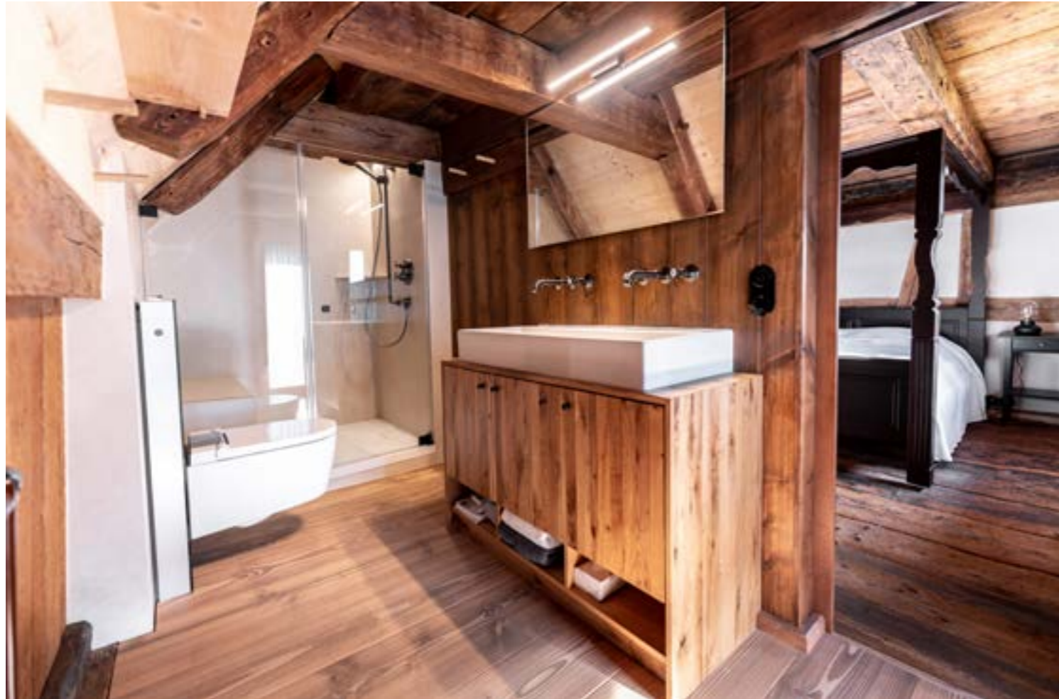
Das Elternbad mit einer angepassten Duschtrennwand zwischen Balken und Dachschräge sowie einer Duschnische mit Sitzbank. Hier wurde auch eine Dusch-WCKompletanlage mit Orientierungslicht eingebaut.
