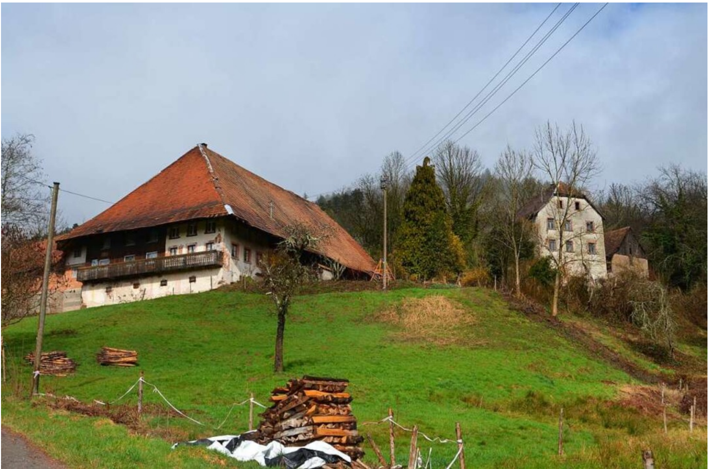
Der denkmalgeschützte Reschhof in Gutach-Siegelau mit seinem Leibgedinghaus. Foto: Nikolaus Bayer
